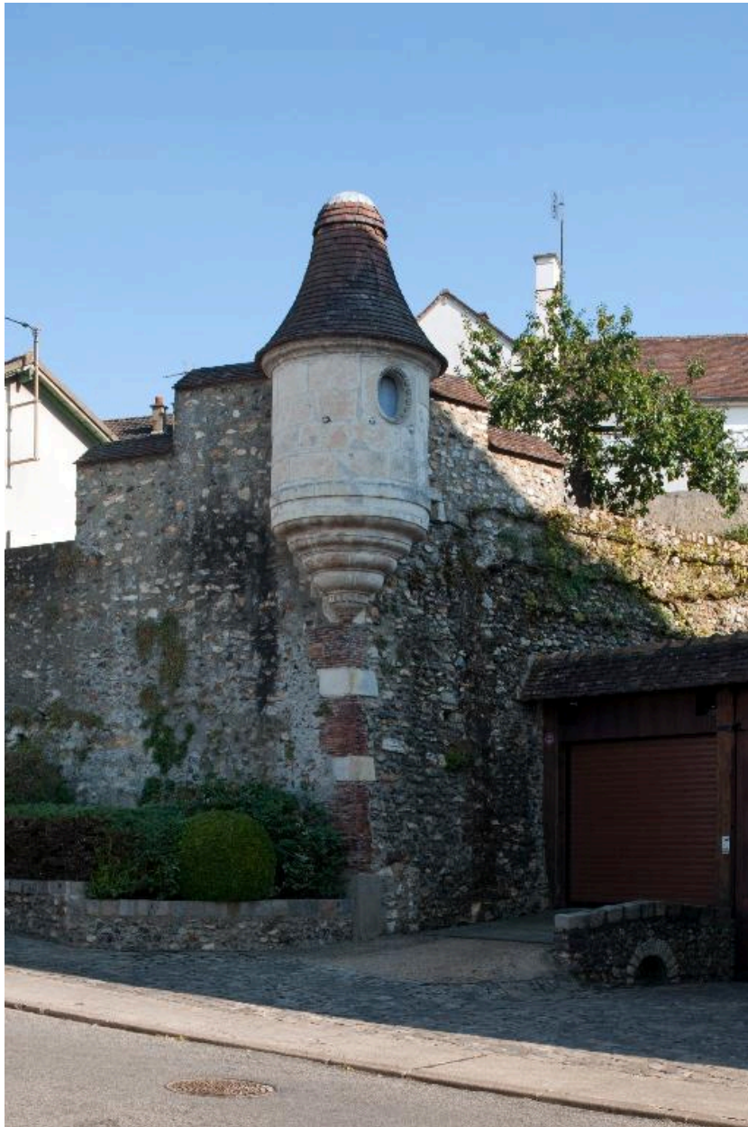
Détail de l'échauguette, vue du sud.
