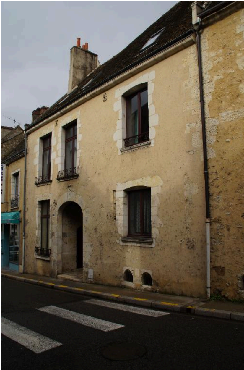
Face sud, vue de sud-est.
