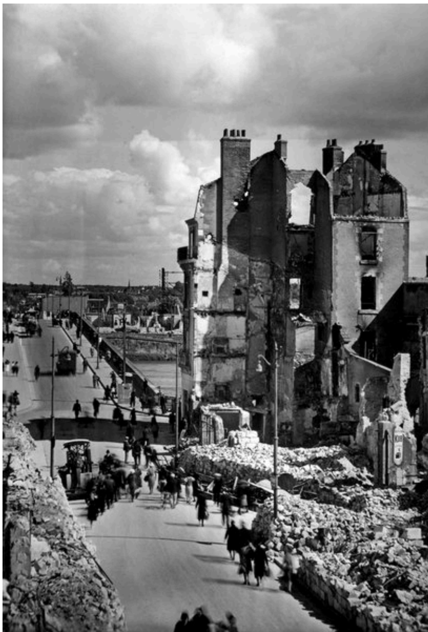
Immeubles en ruines, rue Denis-Papin en direction du pont. A droite, le début de la rue du Commerce, été 1940. (Archives Départementales de Loir-et-Cher, Blois, Fonds Lunais-Bruère, 105 Fi 459).
