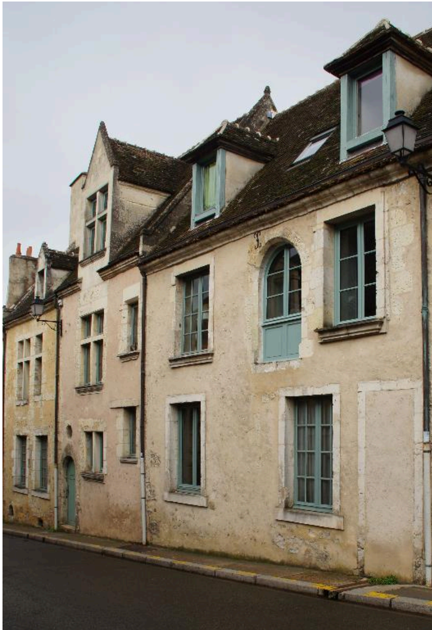
Maisons situées du n°22 au n°24, rue de Sully, vues du sud-est.
