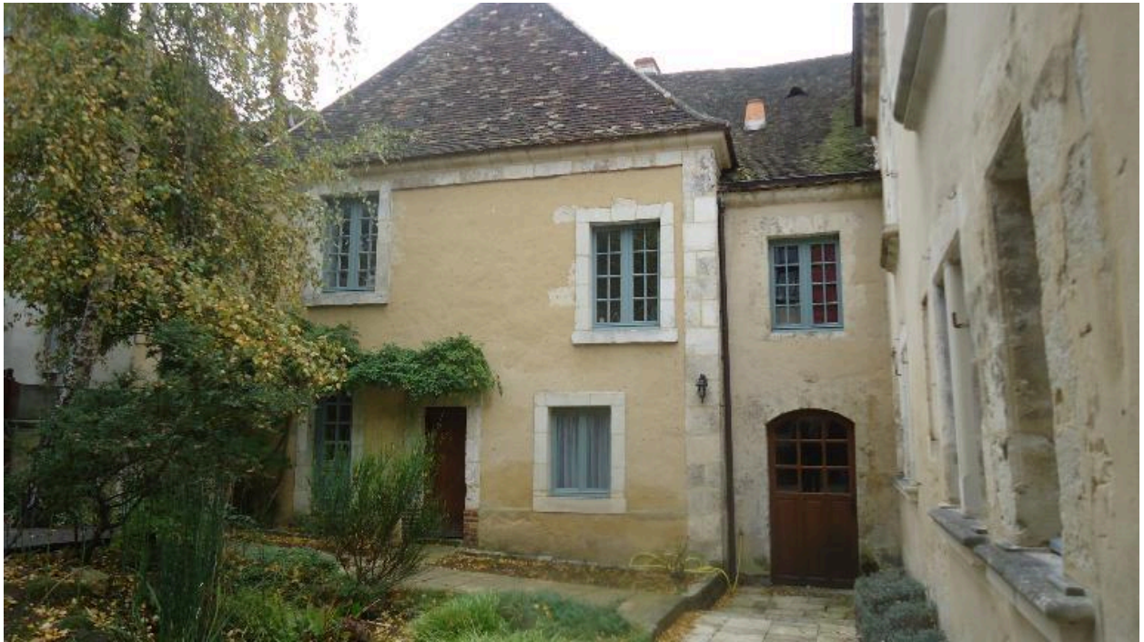
Aile sud, vue du nord.
