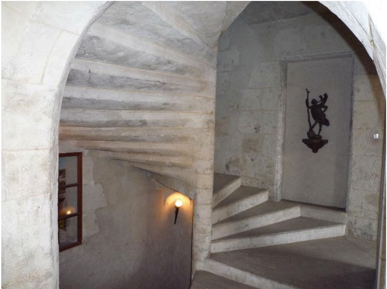
Vue intérieure (bâtiment 3), détail de l'escalier, premier étage.
