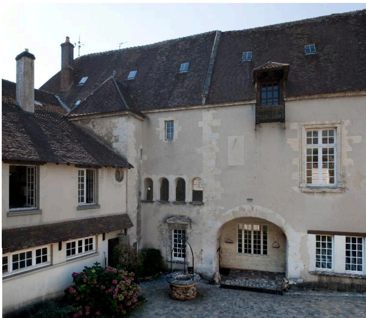
Façades est et nord (sur cour), vue du nord-est.
