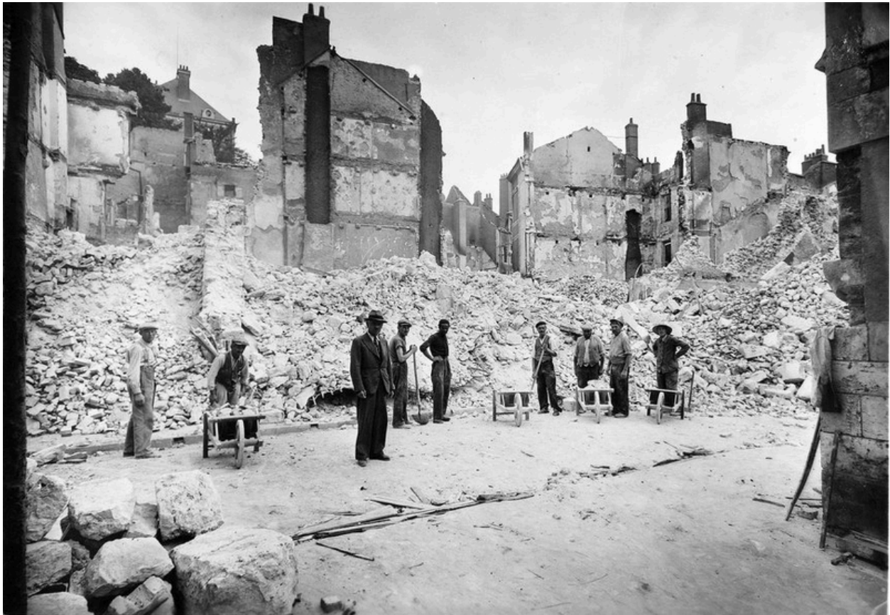
Travaux de déblaiement, place Louis-XII, 1940. (Archives départementales de Loir-et-Cher, Blois, 127 J 70).
