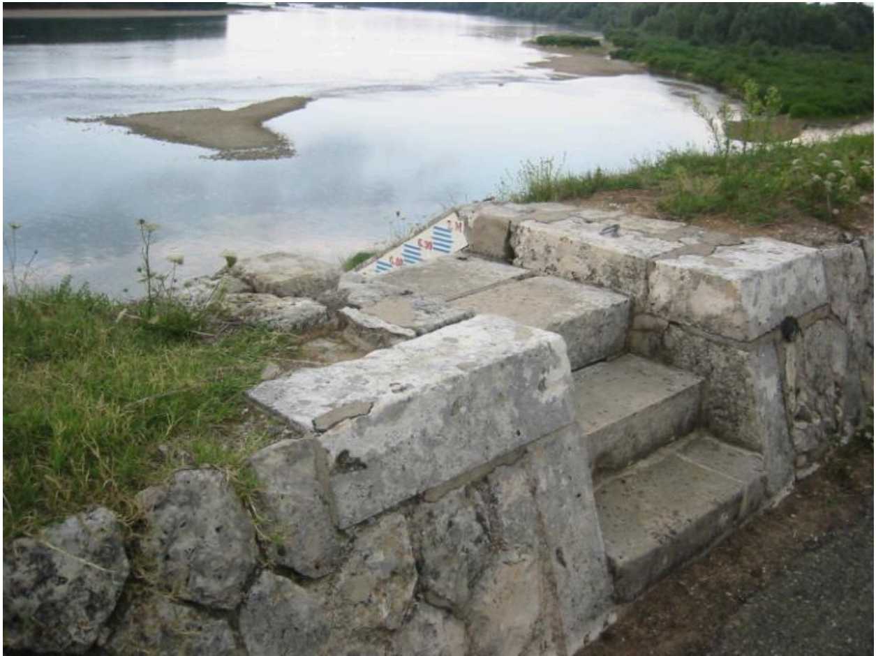
Perré en aval du hameau de Bouteille : escalier.
